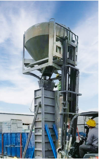
Concrete Pouring / 浇筑图
